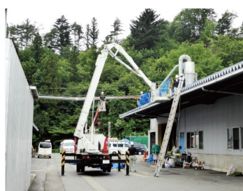
屋根のテント掛け作業が始まりました。
