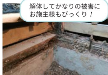
白アリ被害と漏水による土台腐食
