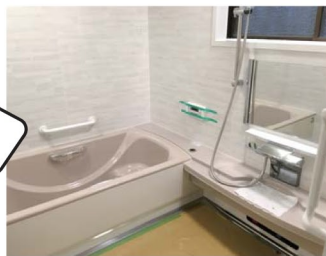
ユニットバス設置
