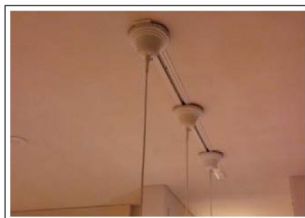
専用部材を付け足して、天井に埋め込んで います。天井とフラットなので、スッキリ して見えます。これが荻野のこだわり。
