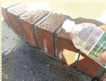
まず、水で湿らせます。 次に「 木酢液 」をかけて馴染ませる様にブラシで擦ります。
