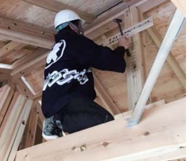
棟梁がしっかりと取り付けくれました
