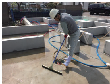
基礎工事中は、基礎の中に雨水が溜ります。多い時には5センチ以上溜まるんですよ！社内基礎完成検査時にポンプで吸い出します。
