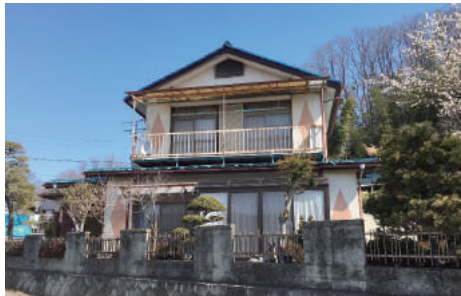
入社して初めての新築工事 沼田市E様邸(昭和 56年) 現在もアフターメンテナンスにお伺いしています。
